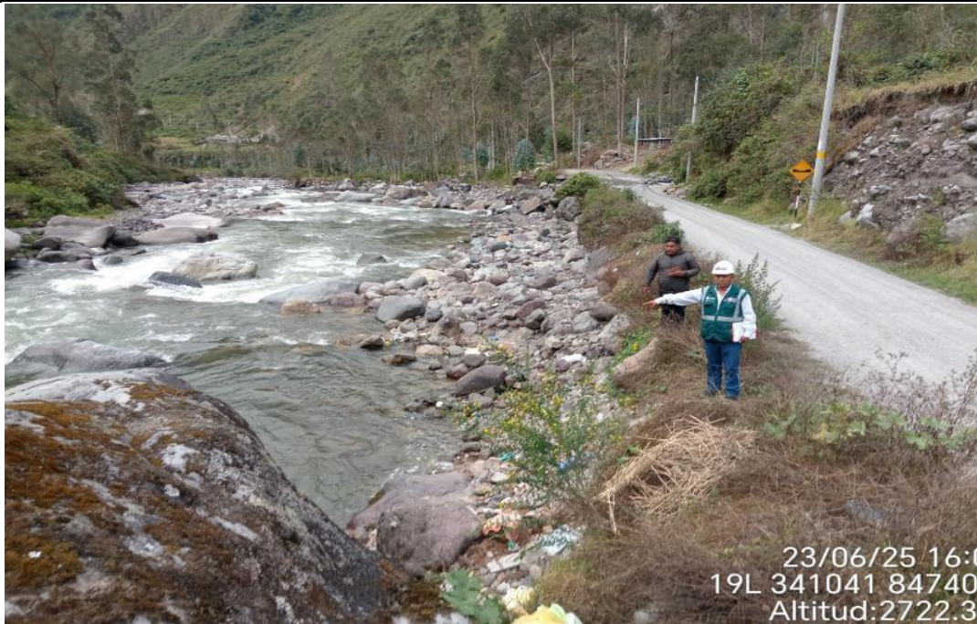
FOTO N° 01: SE MUESTRA LA MÁRGEN DEL RIO OLLACHEA, QUE CAUSA SOCAVAMIENTO EN LA MÁRGEN DERECHA.
